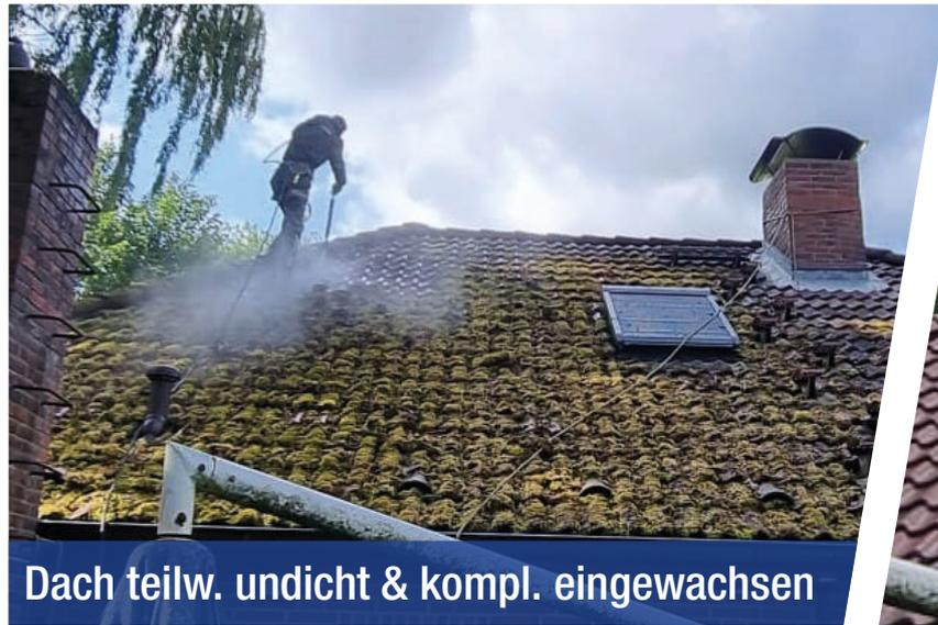
Dach teilw. undicht & kompl. eingewachsen
